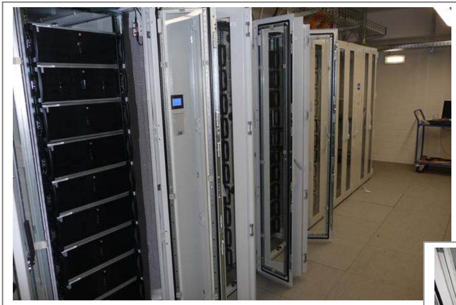
66x sysGen GPU-based HPC-Clusternodes, integriert in wassergekühlter Rittal Rimatrix5-Umgebung...
